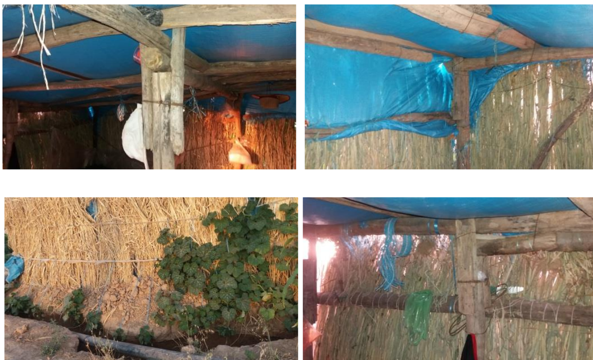
تصاویر ۸ تا ۱۱: نمای داخلی از سازه چوبی و نی‌ها، و نمای خارجی کانال‌کشی برای رشد گیاه رونده Fig. 8-9-10-11: Inner view of wood and reed structure of Kula; and outter view of them with water canals for growing creeping plants
